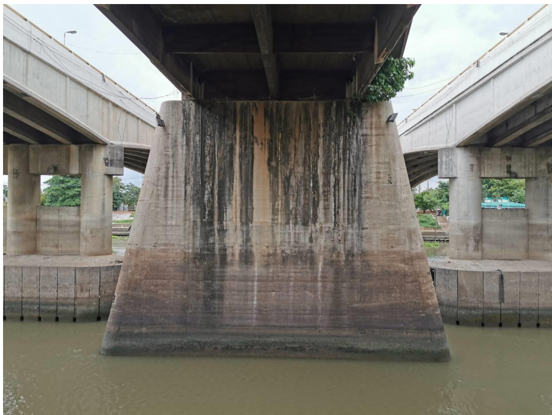
รูปที่ 10-10 กำแพงตอม่อสะพาน (Pier Wall)
