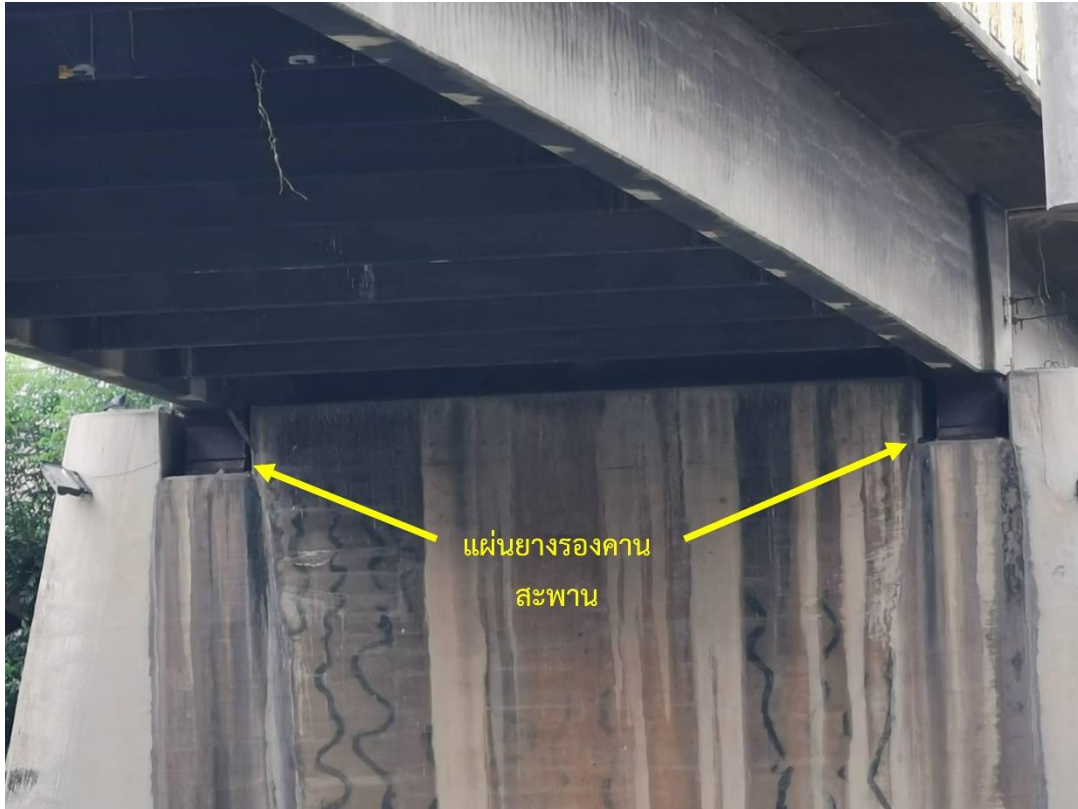
รูปที่ 10-11 แผ่นยางรองคานสะพาน
