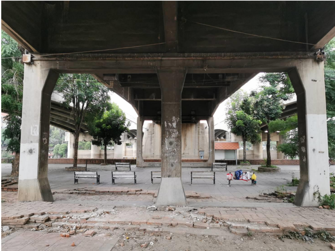
รูปที่ 10-9 เสาคอนกรีตและตอม่อสะพานสำหรับสะพานช่วงเชิงลาด
